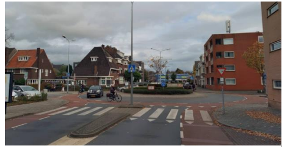
Figuur 5-4 Rotonde Scharnerweg-Sibemaweg. Bron: Cyclomedia november 2023.
